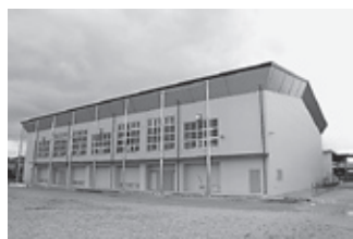
▲緑ヶ丘中学校屋内運動場
