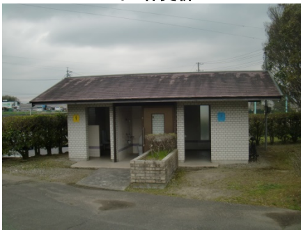
トイレ棟更新
