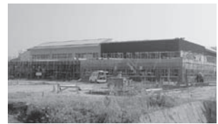
▲城東中学校（建設中）
