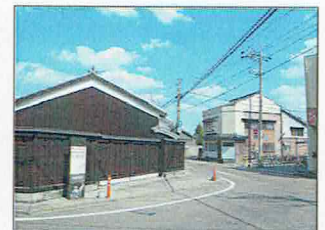
板塀による修景
