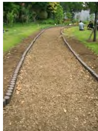
舗装材としての活用事例
