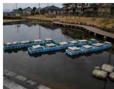
木炭浄化（接触酸化法の一つ）
