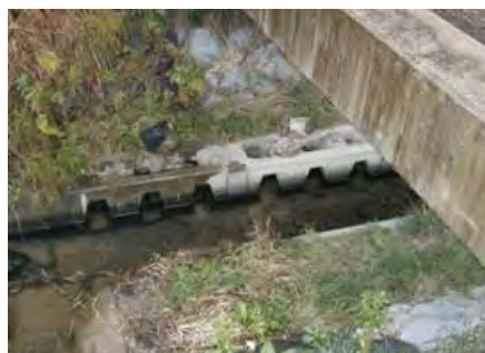
多孔コンクリート護岸
