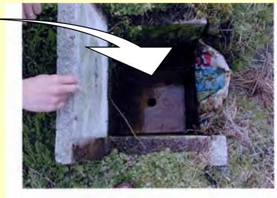
排水調整板設置状況
