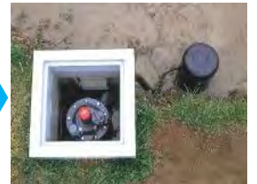
給水栓の自動化へ改良
