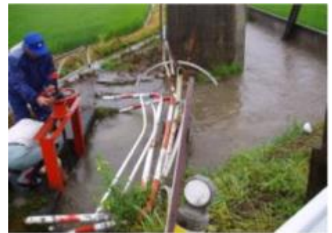
ゲートへのごみや流木の流入状況
