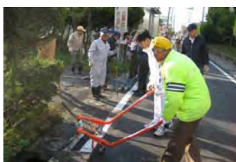
コンクリート蓋設置例
