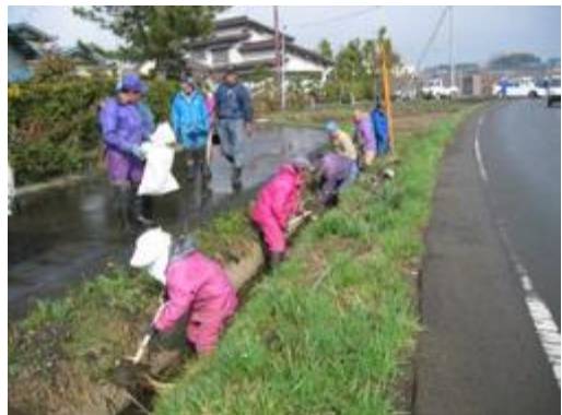
側溝の泥上げ
