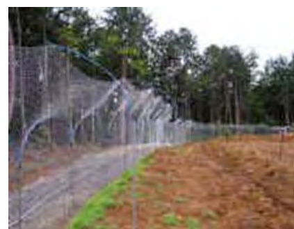
防護柵設置状況
