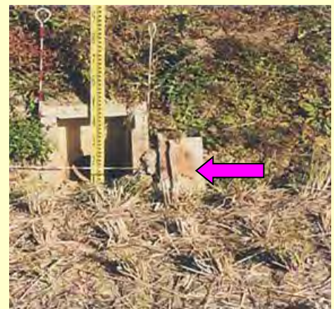
排水調整板設置状況
