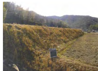
高低差のある畦畔法面
