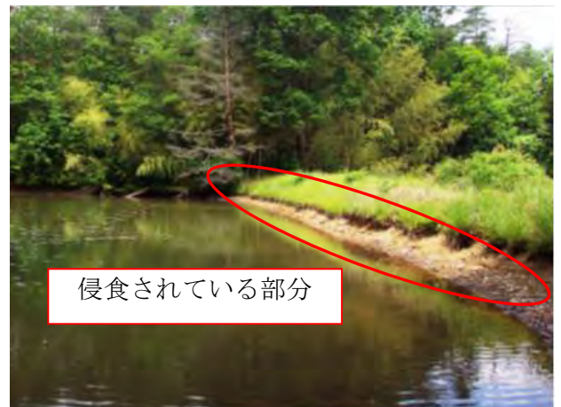
侵食が生じているため池堤体
