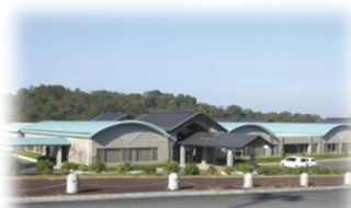
いがまち保健福祉センター （保健施設）
