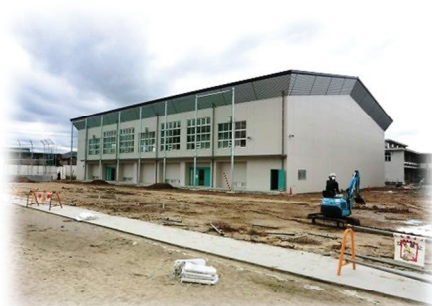
緑ヶ丘中学校屋内運動場 （平成23年建替え）
