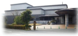
伊賀市文化会館 （ホール）
