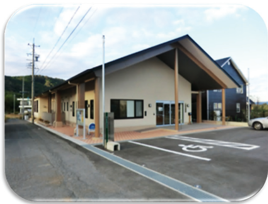
きじが台地区市民センター
