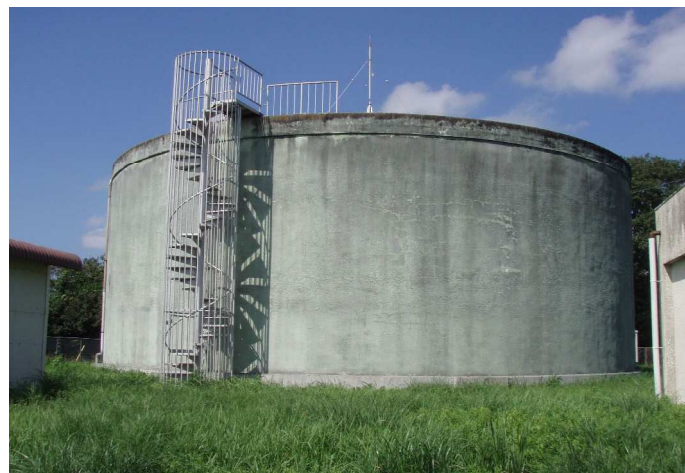
耐震対策済みの施設(伊賀第1配水池)
