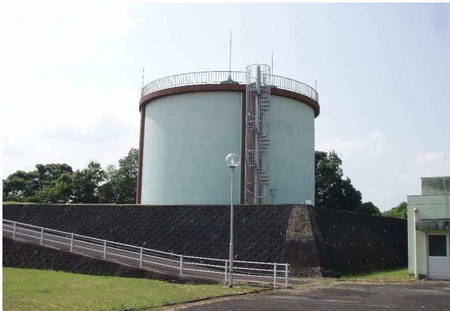
ゆめが丘浄水場からの水が送水される玉滝配水池
