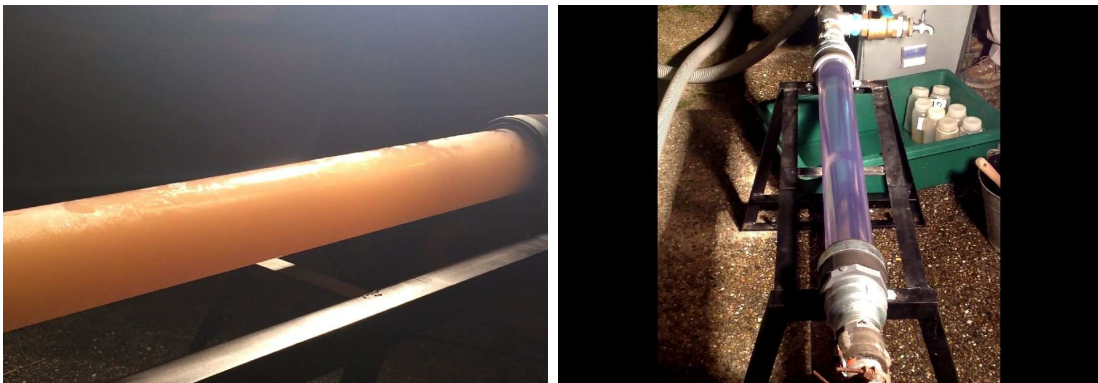
管路洗浄による効果(左:作業中、右:作業後)(アイスピグ洗浄工法※)
