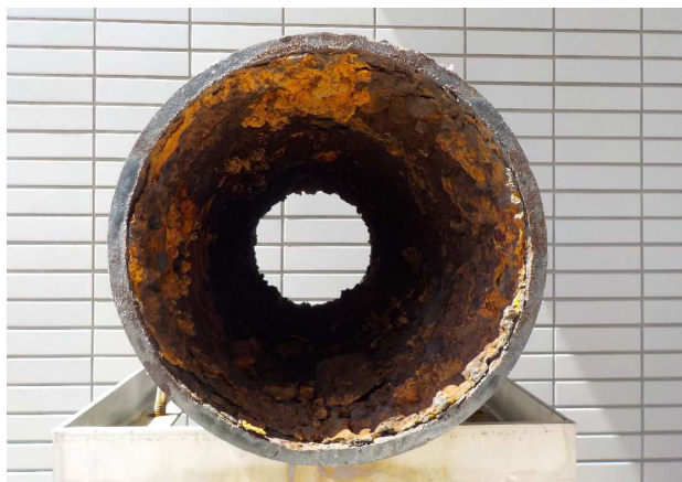
無塗装管路(口径 250mm)の錆コブ (昭和 10 年度布設で平成 23 年まで使用されていた)
