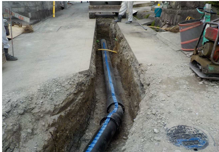
管路の耐震化更新工事
