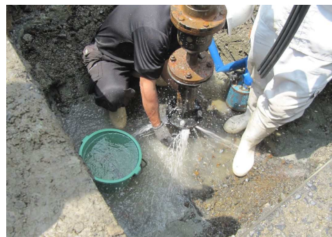
漏水補修作業
