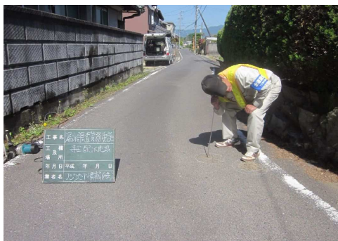
漏水調査作業状況
