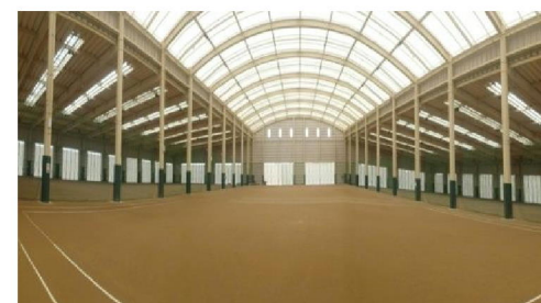
☆多目的グラウンド（内部）
