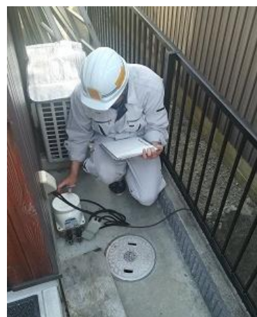
図5 合併処理浄化槽ブローの点検状況
