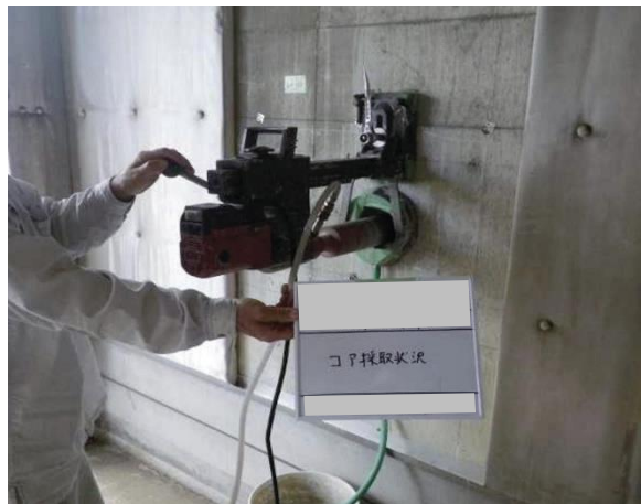
図1 処理場（躯体）の耐震診断 （コア採取状況）
