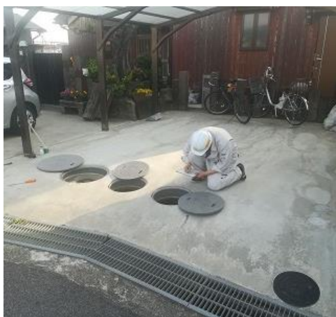
図4 合併処理浄化槽の点検状況
