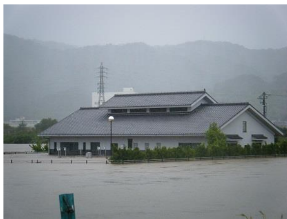
図3 大雨による処理場の浸水状況
