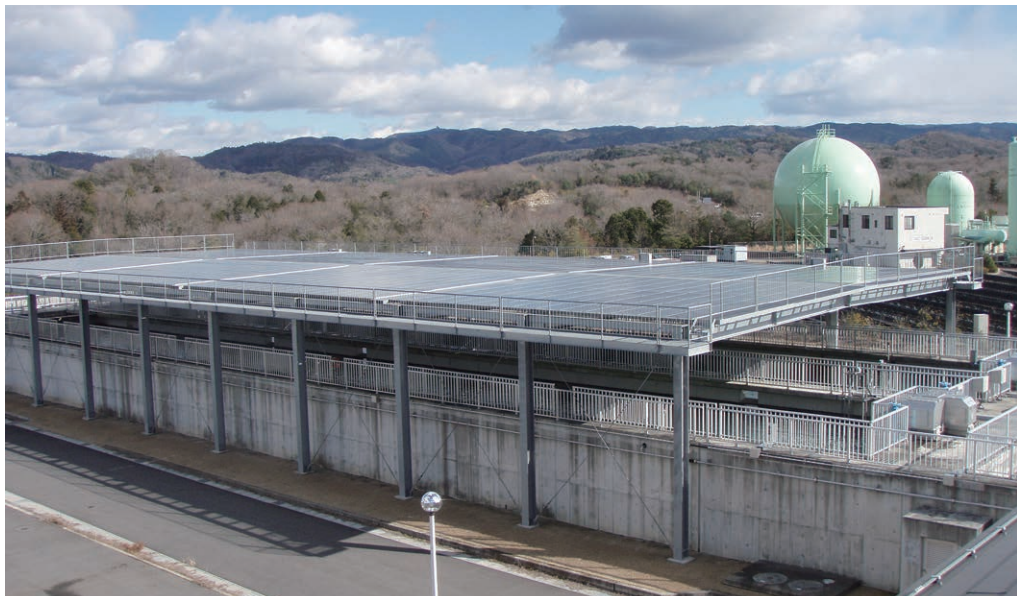
ゆめが丘浄水場太陽光発電設備
