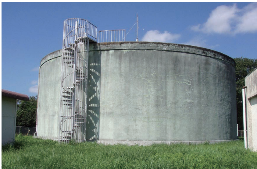
耐震対策済みの施設 (伊賀第1配水池)
