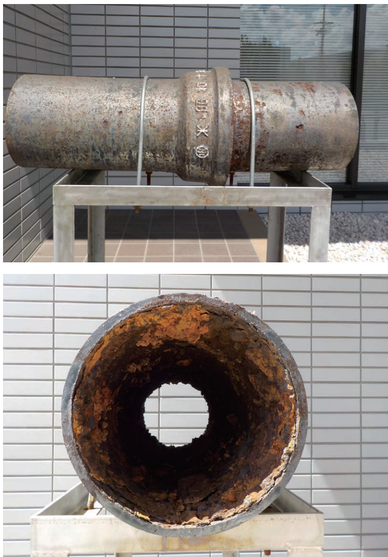
無塗装管路（口径250mm）の錆コブ （昭和10年度布設で平成23年まで使用されていた）
