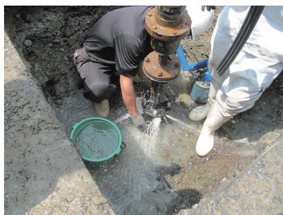
漏水補修作業
