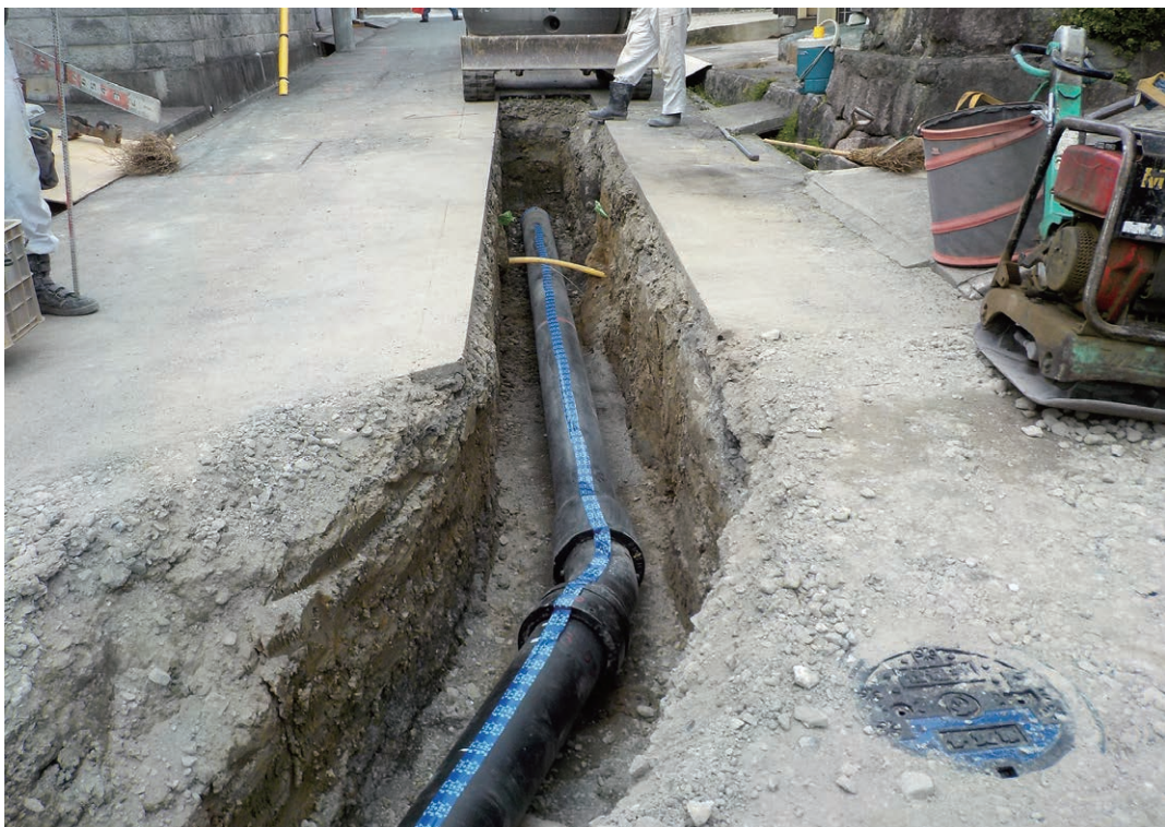
管路の耐震化更新工事
