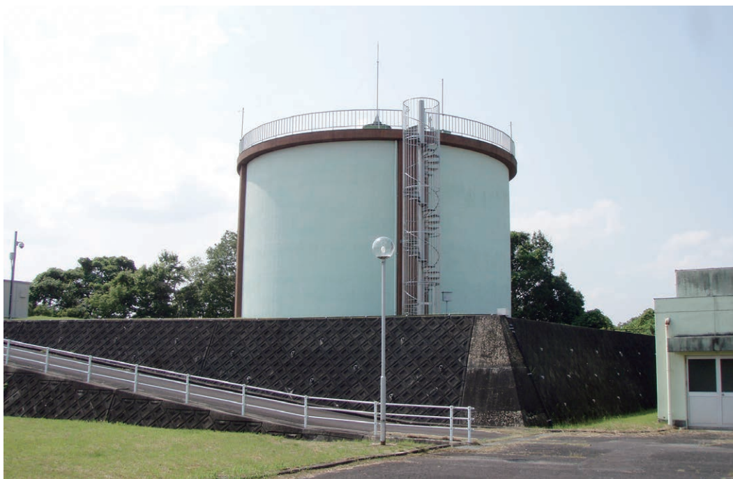
ゆめが丘浄水場からの水が送水される玉滝配水池
