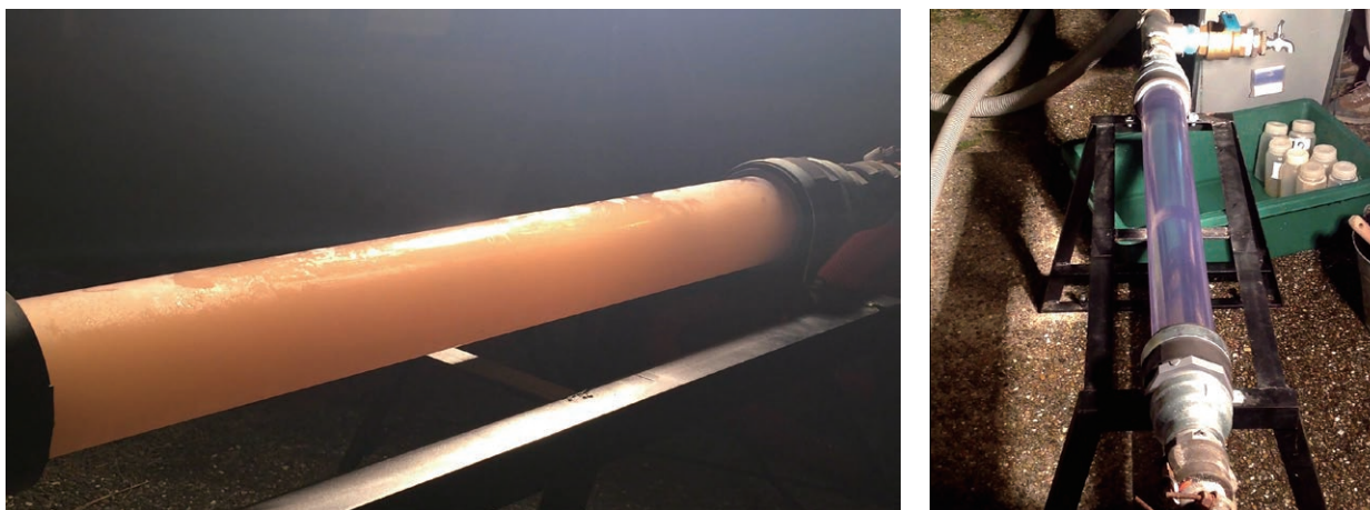
管路洗浄による効果（左：作業中、右：作業後）（アイスピグ洗浄工法 ※ ）
