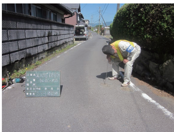
漏水調査作業状況
