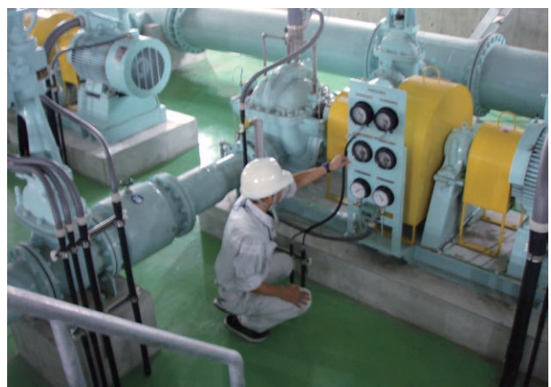
施設管理（ポンプ室）
