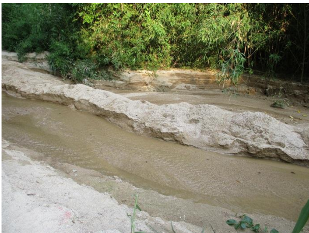
土砂が堆積した川（上流）
