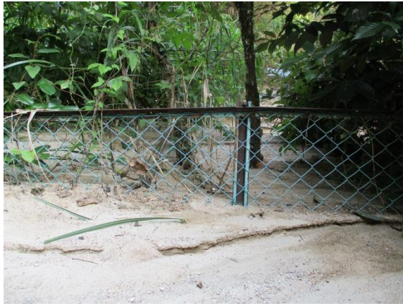
土砂に覆われたフェンス
