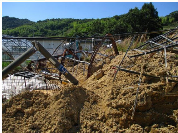
土砂により潰されたビニールハウス
