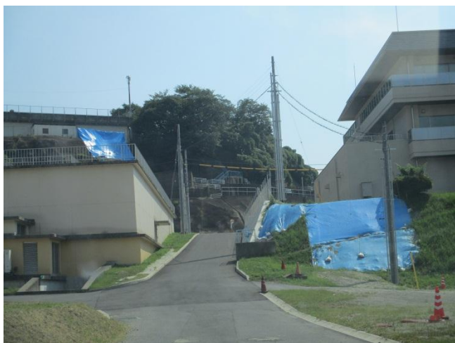
一部被害を受けた宮原浄水場
