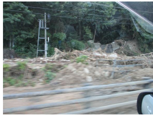
国道31号線沿いJR呉線（不通）
