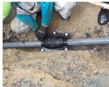
漏水修繕の様子
