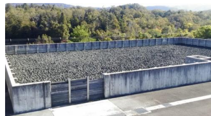
ゆめが丘浄水場 天日乾燥床
