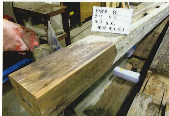
補修完了・根継（ねつぎ）
