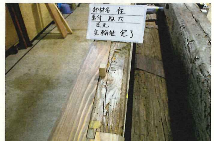
補修完了・金輪継（かなわつぎ）
