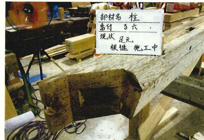
損傷箇所除去
