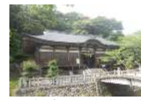
▲春日神社拝殿解体修理事業
