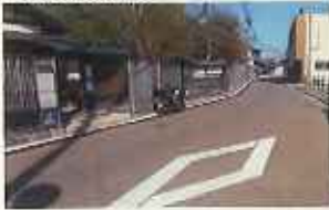
市道農人町八幡町線(施工後)
