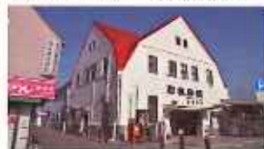
伊賀鉄道上野市駅舎
