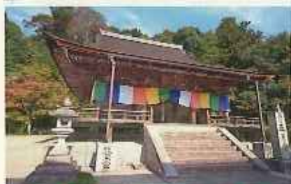
観音提寺本堂防火施設等設置前
