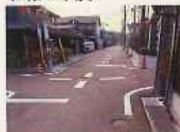
市道小田西明寺線(施工後)
