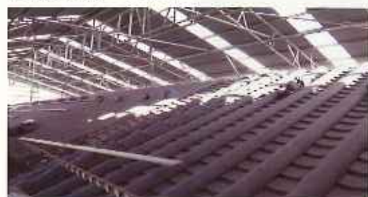
令和元年度 工事中
