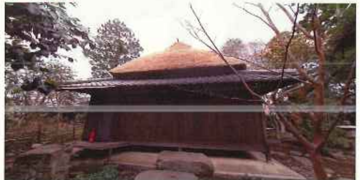
茅葺屋根の葺き替え及び樹木の部分的剪定後
