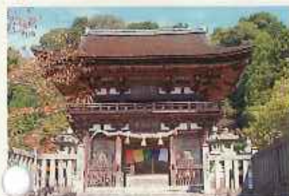
観音提寺楼門防火施設等設置前
