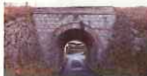
伊賀鉄道小田拱橋
