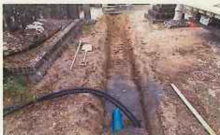
防火施設等掘削工事(楼門)
