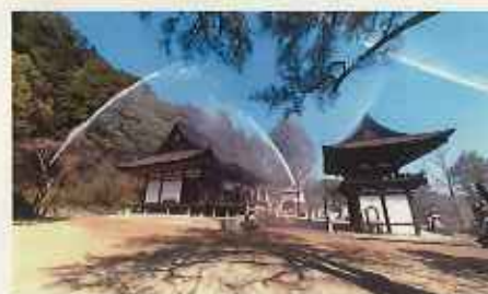
放水銃や易操作性消火栓の放水状況
