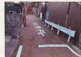
市道愛宕神社線(施工後)
