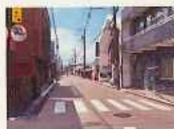
市道農人町八幡町線(施工後)
