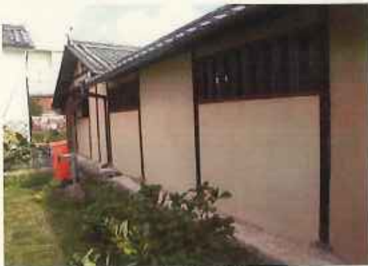
北控所や渡廊下の土壁修理後
