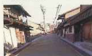
市道丸之内久米線(施工後)
