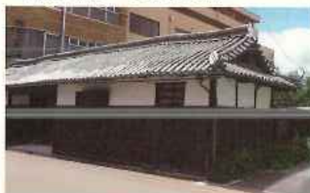
平成29年度 工事着手前
