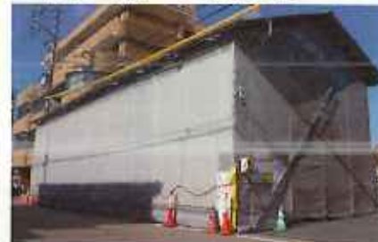
平成30年度 工事着手後
