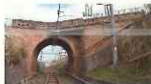
伊賀鉄道桑町跨線橋
