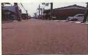
市道農人町八幡町線(施工後)
