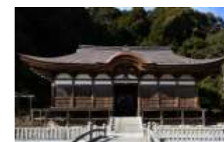
▲春日神社拝殿解体修理事業
