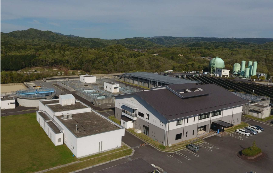
ゆめが丘浄水場
