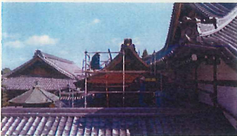
保護網設置状況
