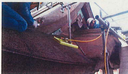
保護網設置状況
