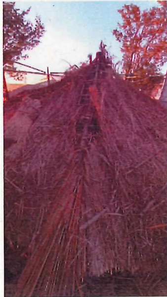
芭蕉堂茅葺除去状況
