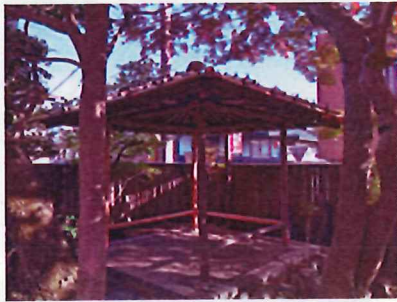
月見堂屋根葺き替え補修後
