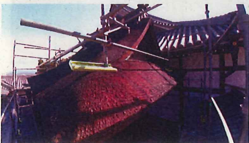
保護網設置状況
