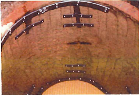
胴内部の割れ修理
