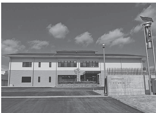
ゆめが丘浄水場施設【管理棟正面】
