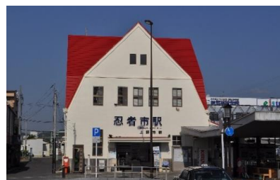
伊賀鉄道上野市駅舎
