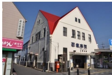
伊賀鉄道上野市駅舎
