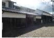
長屋門・蔵・石柱門
