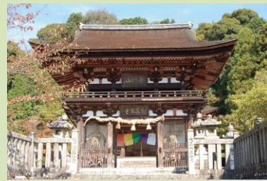
▲観音提寺本堂・楼門 防災設備保守点検事業
