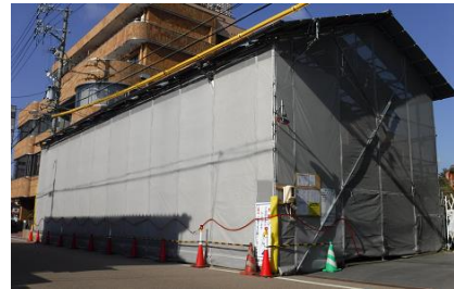
平成30年度 工事着手後
