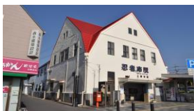
伊賀鉄道上野市駅舎
