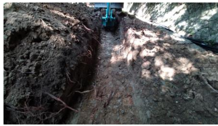
防火施設等掘削工事(本堂)
