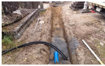
防火施設等掘削工事(楼門)
