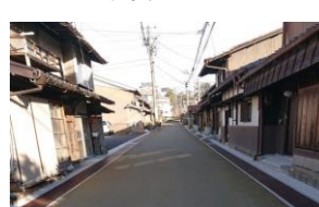
市道丸之内久米線(施工後)
