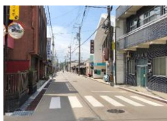
市道農人町八幡町線(施工後)
