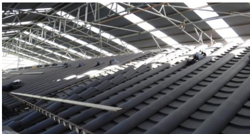
令和元年度 工事中
