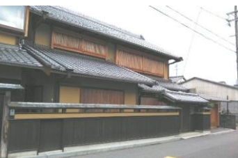
修理後(外壁のクリーニングと再塗装)
