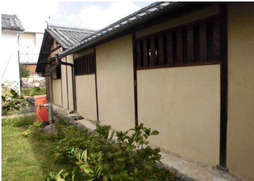
北控所や渡廊下の土壁修理後
