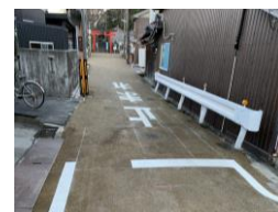
市道愛宕神社線(施工後)
