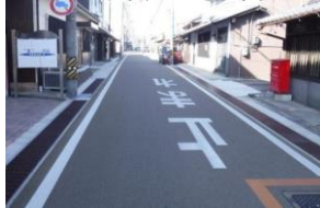
市道愛宕町恵美須町線(施工後)
