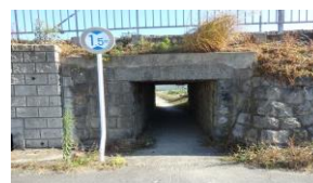
伊賀鉄道小田第二暗渠
