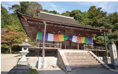
観菩提寺本堂防火施設等設置前
