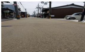
市道農人町八幡町線(施工後)
