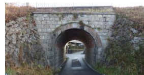
伊賀鉄道小田拱橋
