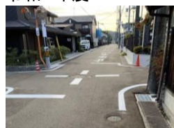
市道小田西明寺線(施工後)
