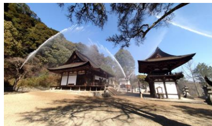
新設した首振り式放水銃の放水状況
