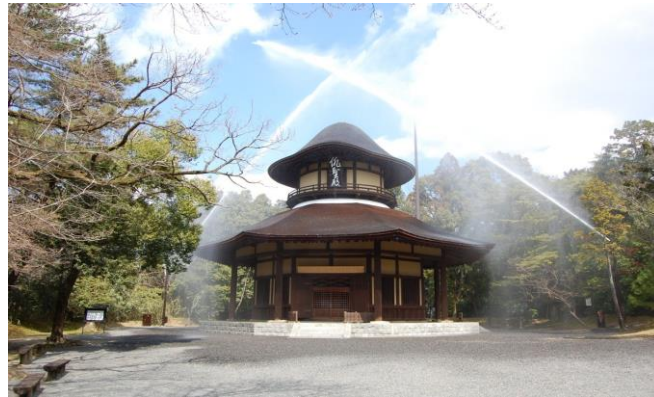
俳聖殿での一斉放水状況
