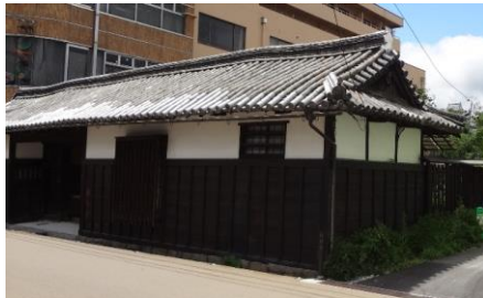
平成29年度 工事着手前
