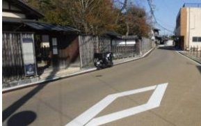
市道農人町八幡町線(施工後)
