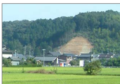
屋並みの美しい集落と 切土された法面（他市）
