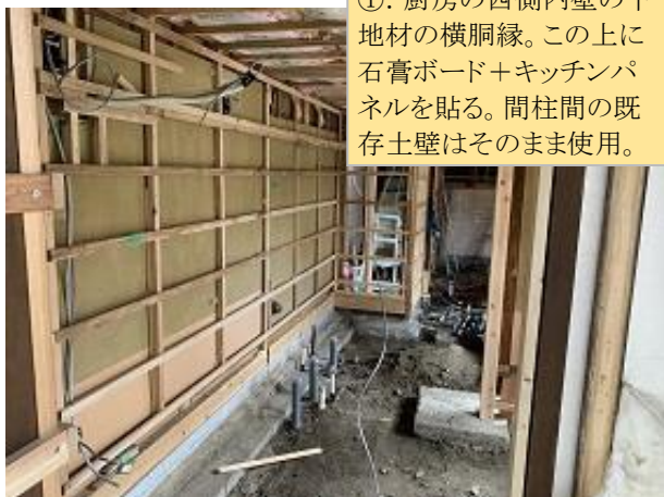
③. 事務所棟の既設トイレを厨房に改修、間仕切り壁の設置。
