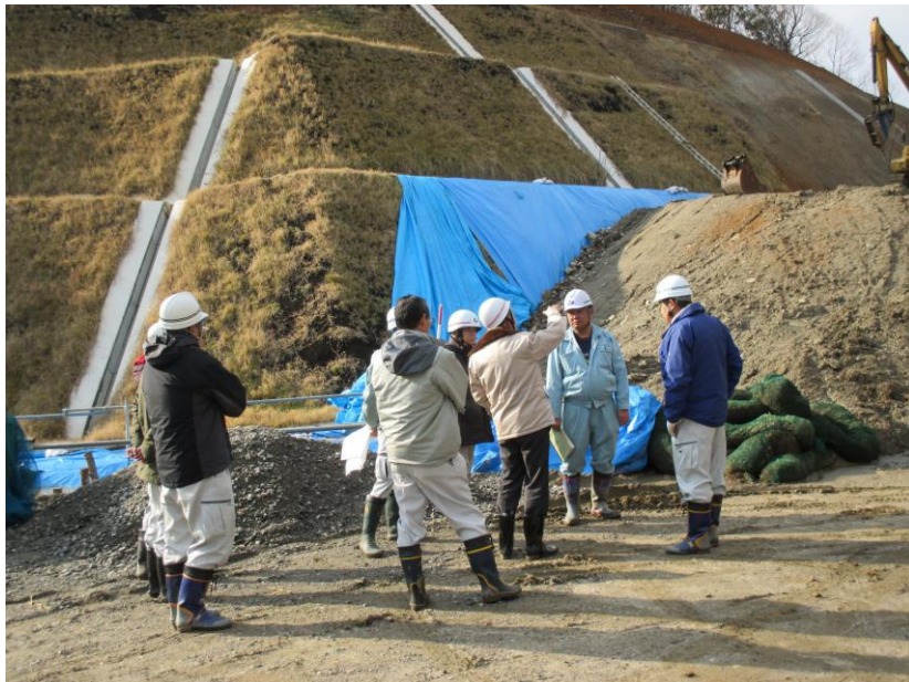
③山の開削箇所（下のブルーシートは濾過フィルター付き沈砂池）
