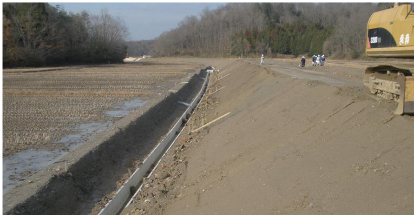
③山の開削箇所（下のブルーシートは濾過フィルター付き沈砂池）
