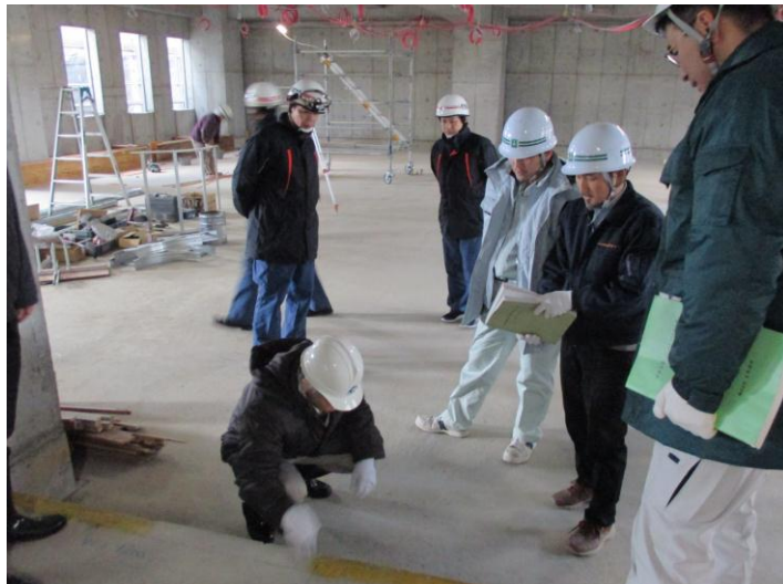
③新消防庁舎棟内検査写真 II（免震床箇所）
