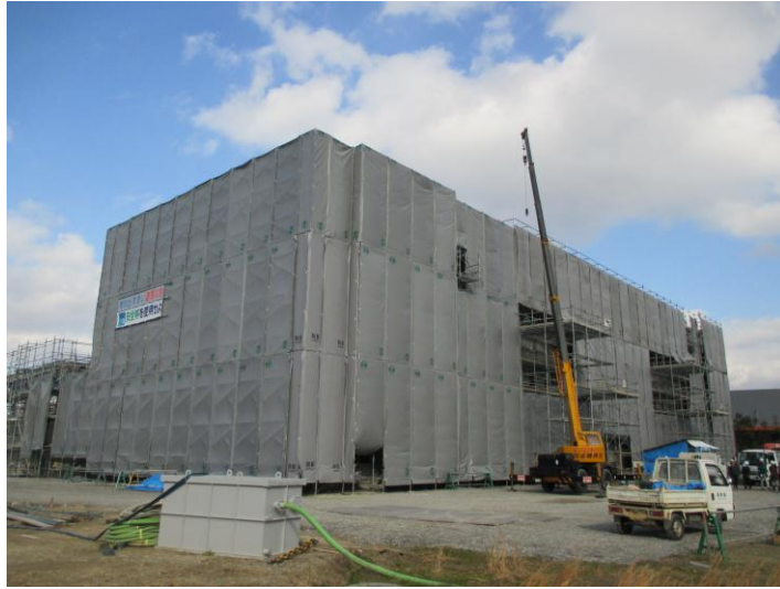
①新消防庁舎工事全体写真
