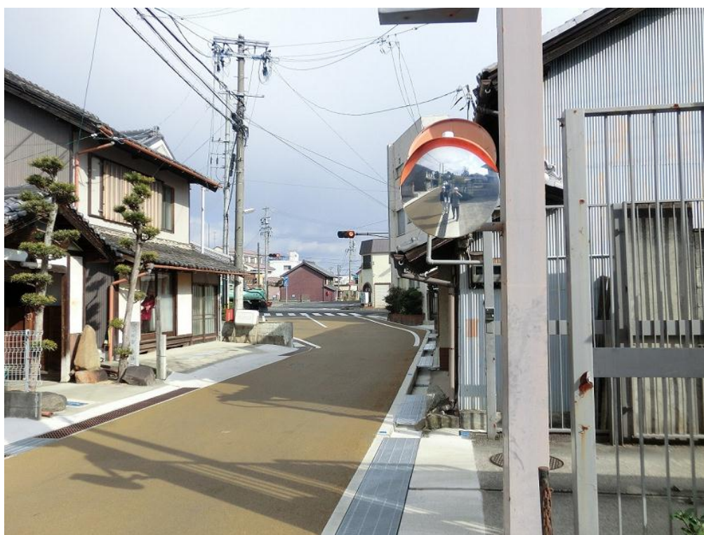
(写真奥)工事終点 No.13+1.87
