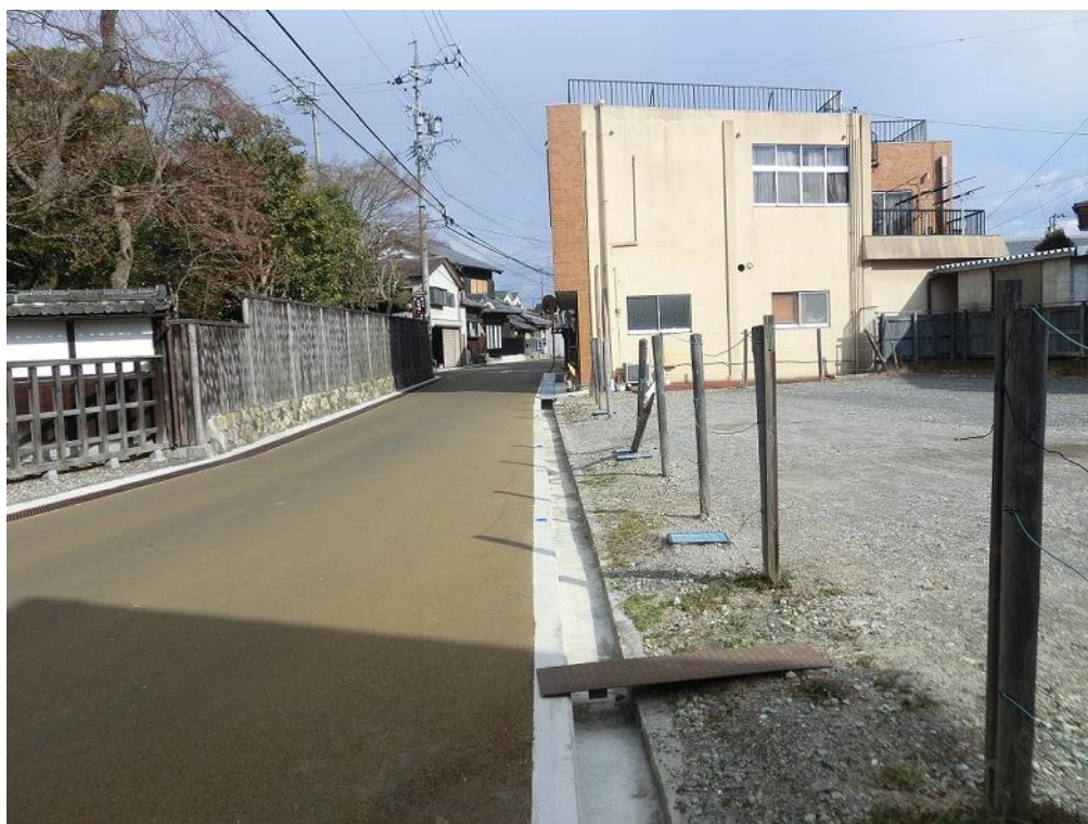
No.3～No.5 付近 (写真右)現場打ち水路工
