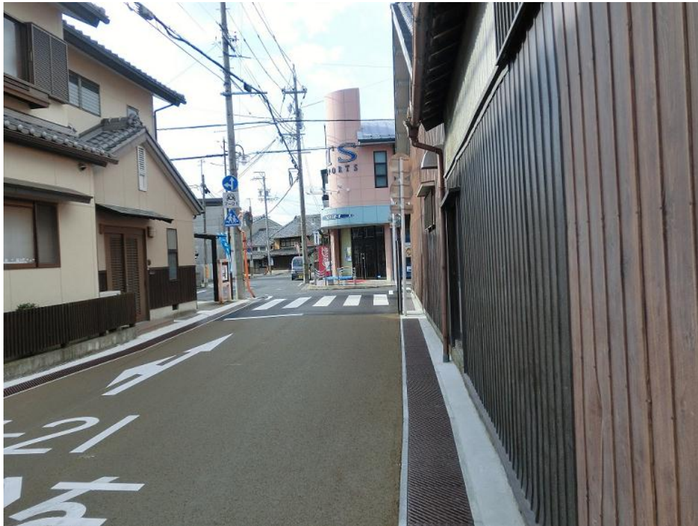
(写真奥) 工事起点 No.0+2.0
