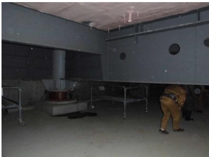
③ 伊賀市庁舎棟内検査写真Ⅱ（免震箇所）
