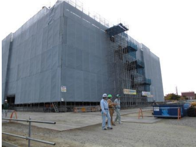
① 伊賀市庁舎新築工事全体写真
