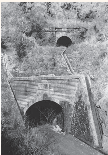
▶長野トンネル(上…初代、下…2代目) 『美里村史』上巻から)
