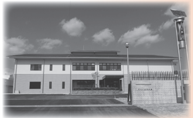
▼ゆめが丘浄水場
