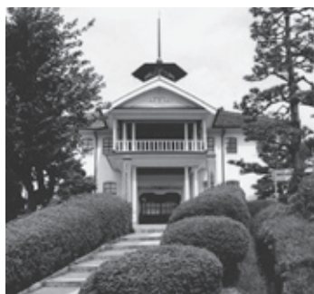
▲旧小田小学校本館
