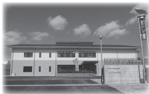
▼ゆめが丘浄水場
