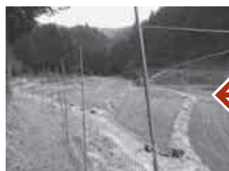
諸木地区（再生作業後）
