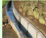
コンクリート水路の更新
