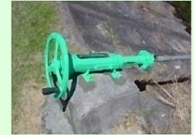
ゲート、バルブの更新
