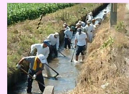
水路の泥上げ
