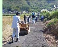
未舗装農道の舗装
