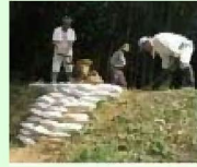
漏水箇所の補修
