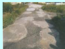
農道の窪みの補修
