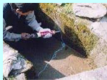
水路のひび割れ補修
