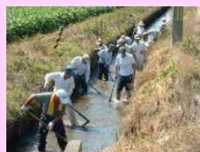
水路の泥上げ
