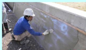
老朽化した水路壁のコーティング
