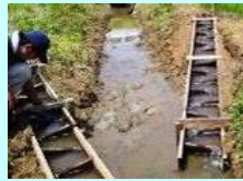
水田魚道の設置
