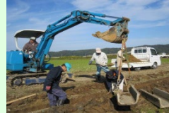
コンクリート水路の更新
