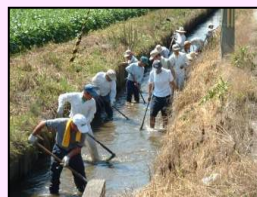
水路の泥上げ
