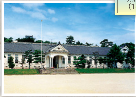
三重県第三尋常中学校(現上野高等学校)設置①
