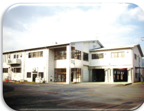
浄化センター処理場
