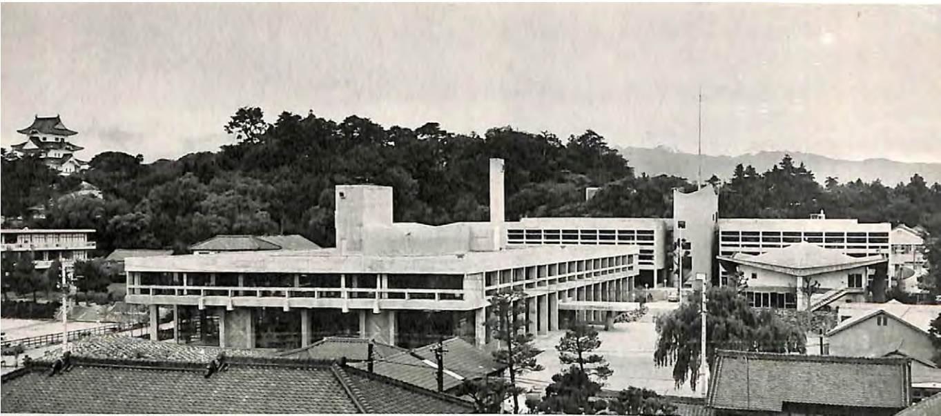
新築時の庁舎の南側からの俯瞰 奥に三重県総合庁舎、左に公民館が見える
