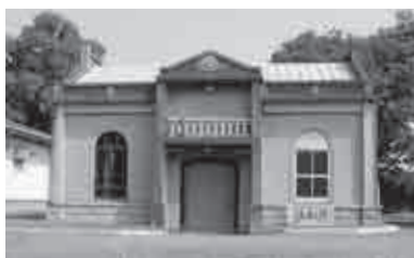
▲上野市上水道水源免费送水機関室
