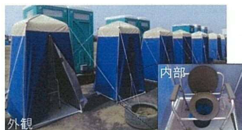
マンホールトイレの使用例
