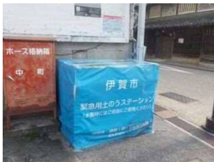
図 3-10 土のうステーション写真
