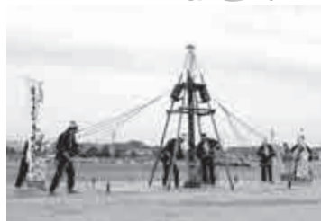
▲伊賀石つき唄保存会による土台の地固め
