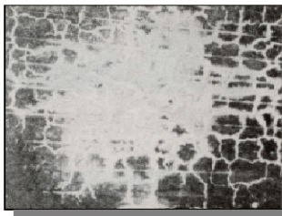
③貫通ひびわれへの進展
