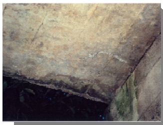
①方向性のひびわれの発生
