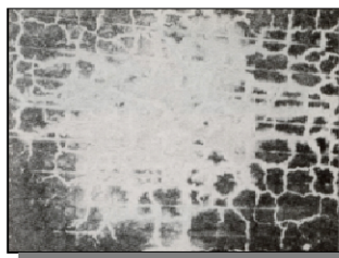
③ 貫通ひびわれへの進展
