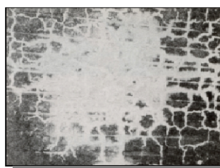
③貫通ひびわれへの進展
