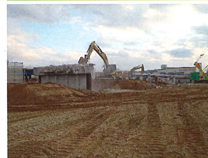
3. 旧橋撤去（下部）
